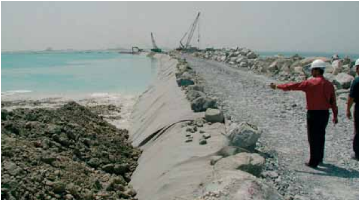
Источник: Пальм-Айленд, Дубай. Установка Fibertex F-650M. Геотекстиль Fibertex будет полностью покрыт песком и гравием.
